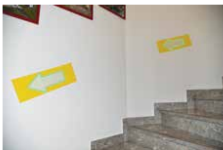
Odsevne in svetleče oznake evakuacijske poti, nameščene nižje, so dobro vidne tudi ob zadimljenosti prostora.
