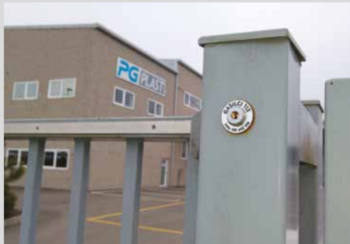
Z gasilskim ključem lahko gasilske enote odpirajo ograje, zapornice, vrata in tako hitreje dostopajo do kraja požara.
