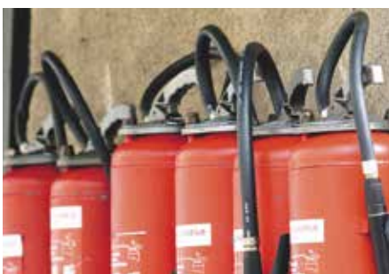
Pregled gasilnikov je treba opraviti vsaj enkrat na leto oziroma po vsaki uporabi.
